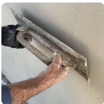
Aanbrengen van de eerste laag FASSA LIMEBOND als lijm- /uitvlaklaag met een vlakke metalen spaan, in een laagdikte van ca. 2,5 mm.
