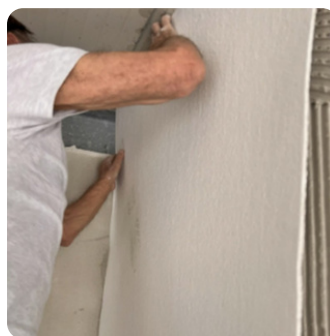
Manueel aanbrengen van FASSA SHIELD in de nog verse lijmlaag.
