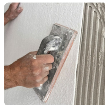
Aandrukken van FASSA SHIELD in de verse lijmlaag met behulp van een sponsbord.
