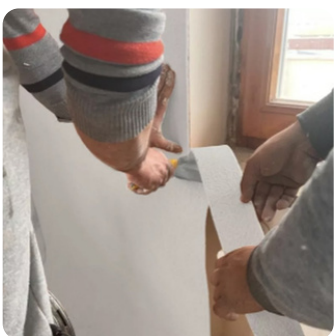
Op maat snijden en aanpassen van FASSA SHIELD aan de vorm van de ondergrond met een scherp mes.
