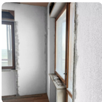
Na het plaatsen van de hoekprofielen zijn de met FASSA SHIELD beklede oppervlakken klaar voor de uitvlaklaag.
