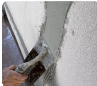
Opvullen van de naad tussen twee banen FASSA SHIELD met FASSA LIMEBOND.
