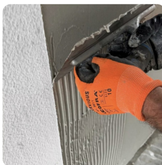
Voorbereiding van de lijmlaag voor het plaatsen van de volgende baan FASSA SHIELD.
