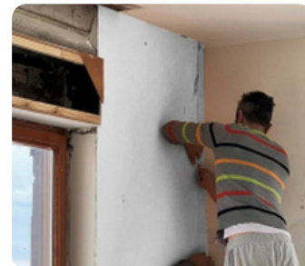
Detail van de plaatsing van FASSA SHIELD.
