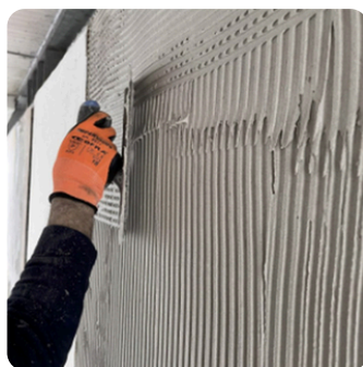
Doorkammen van de FASSA LIMEBOND-laag met een metalen lijnkam.
