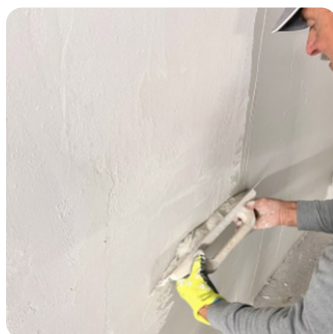
Aanbrengen van de FASSA LIMEBOND-uitvlaklaag met een vlakspaan: twee lagen voor een totale laagdikte van ca. 2 mm.
