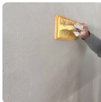
Afwerken en gladzetten van de uitgevlakte oppervlakte met een sponsbord, klaar om te schilderen.
