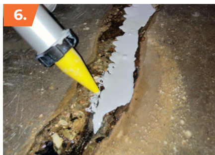
6. Elastische voegkit aanbrengen in de scheur
