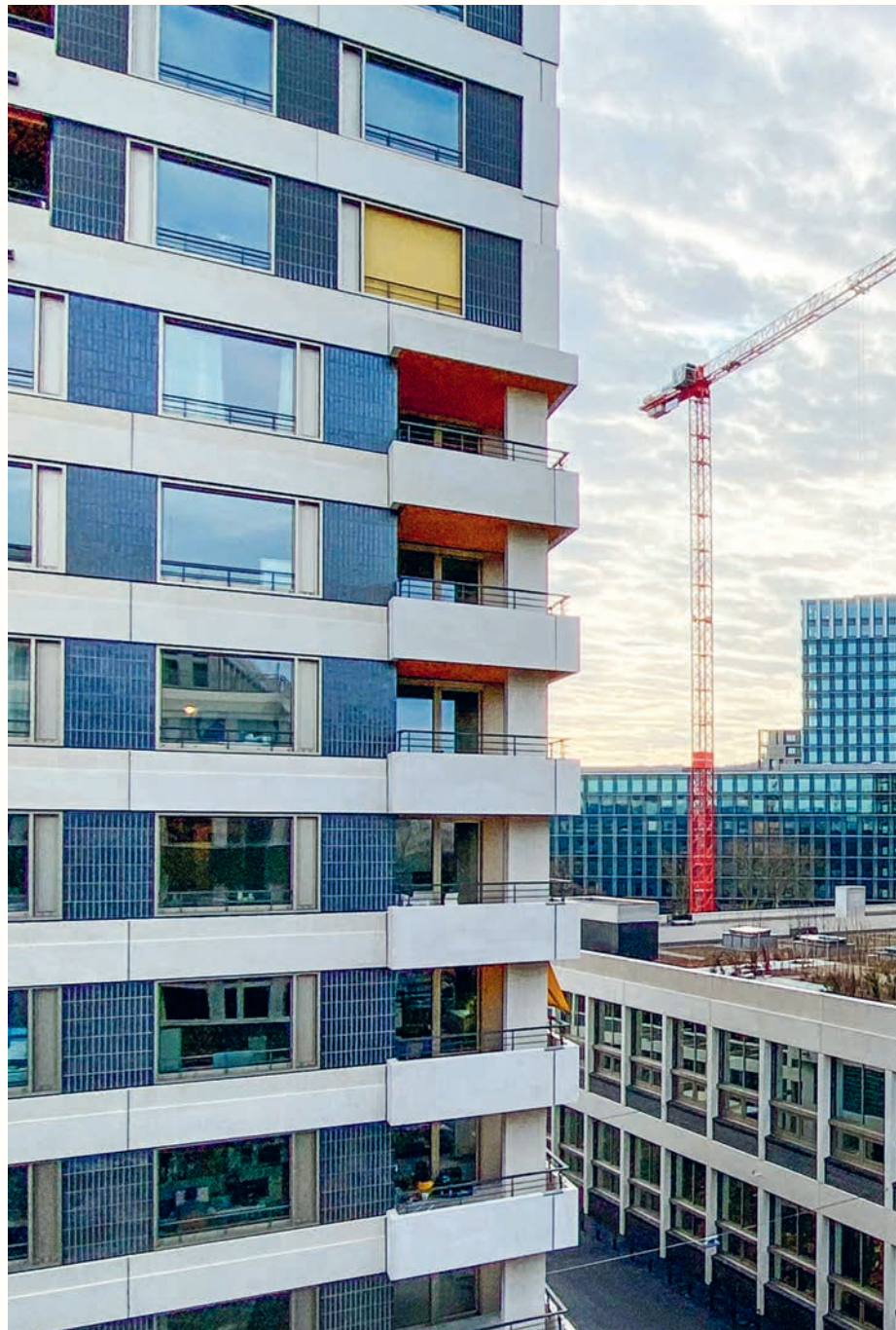
Teil des WolkenWerks: Die neue Fabrik mit dem dazugehörenden Hochhaus an der Leutschenbachstrasse.
