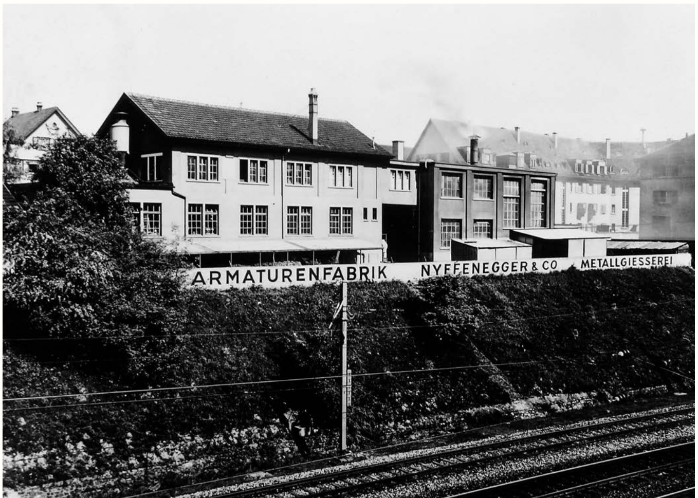
Das Firmenareal mit dem Werkstatt- und dem Giessereigebäude (rechts) Ende der 1920er Jahre, von den Bahngleisen her gesehen. Es blieb in dieser Form bis heute im wesentlichen unverändert.
