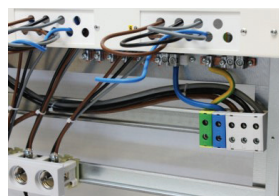
Bilden visar plintar för inkommande anslutning.
