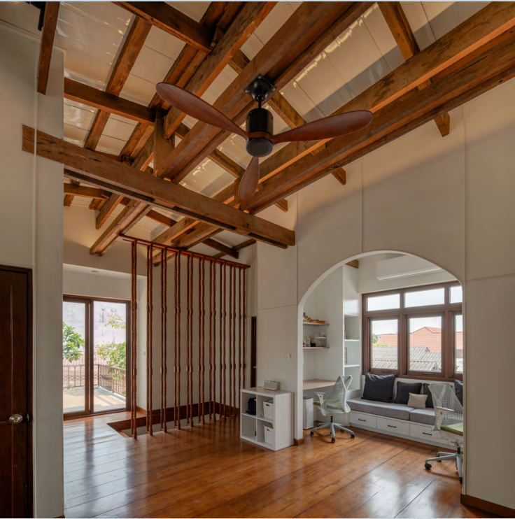
บรรยากาศภายในของ บ้านที่เผยให้เห็นถึง โครงสร้างหลังคาไม้ เดิมของอาคารและท้อง เมทัลชีทแบบแซนวิช พาแนล (Sandwich Panel) ที่ถูกติดตั้งเพิ่ม เข้าไปใหม่
