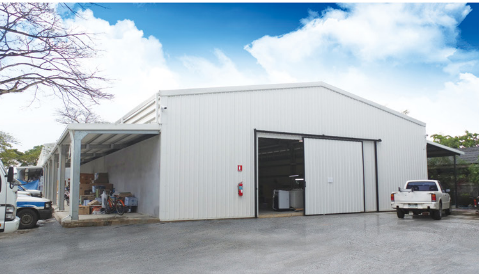
Thanawut Warehouse - Nakhon Si Thammarat
