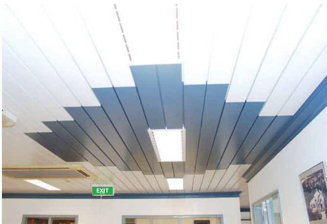
Nhà xưởng / Nhà Kho Workshop / Warehouse
