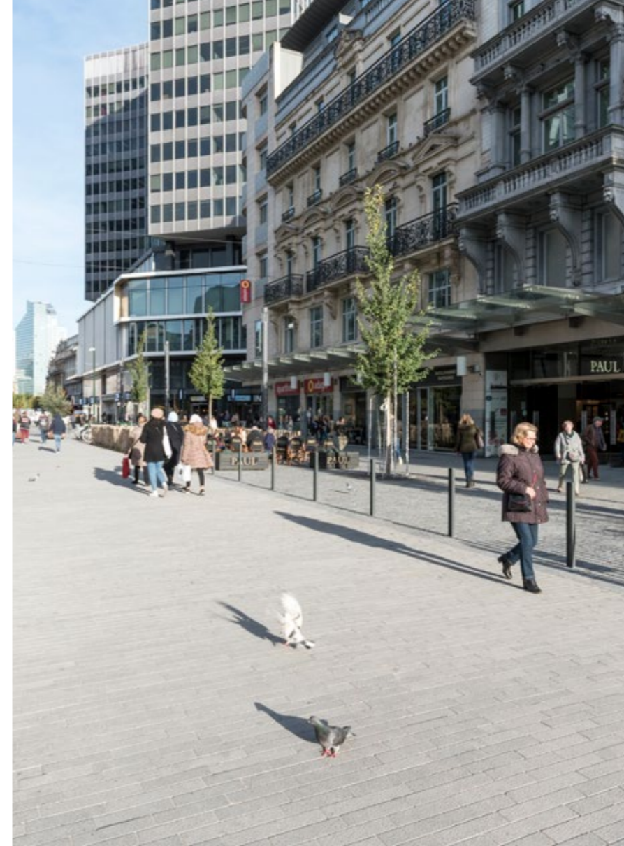
Kilkenney Limestone boucharde, brut de sciage et clivé Boulevard Anspach, Bruxelles (BE)
