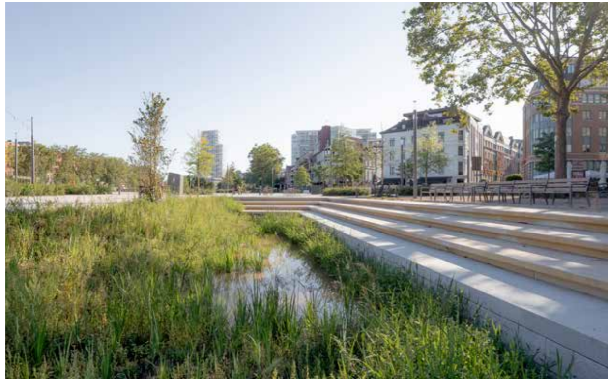
Tarn - massieve blokken en dekstenen - gezaagd - Gedempte Zuiderdokken, Antwerpen (BE)
