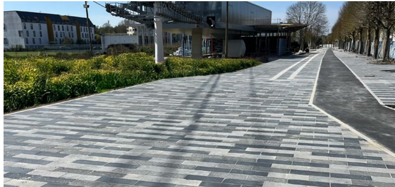
Kilkenny Limestone – flammé, adouci et poli – Project câble C1, Paris (FR)
