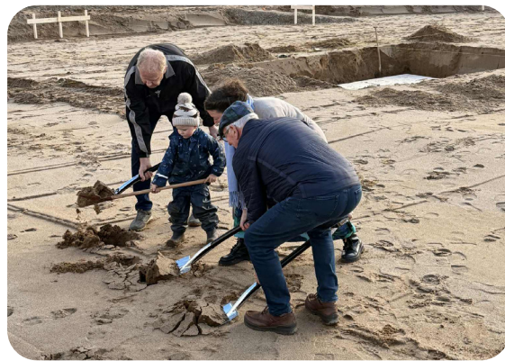
I november tog vi første spadestik til byggeriet af 79 boliger på Præstegårdstorvet midt i Grindsted.
