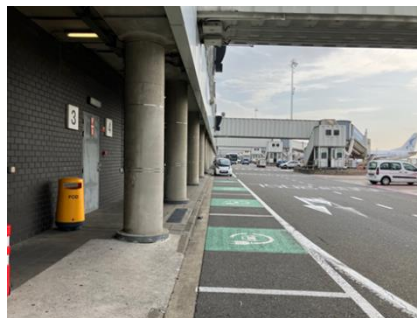
Fig. 22. Parkeerstroken pier B
