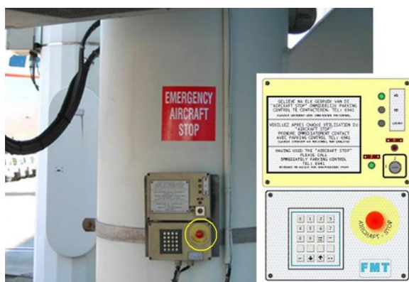
Fig. 54. DGS-noodstop pier B, niveau Tarmac
