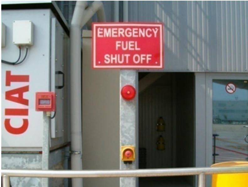
Fig. 57. Arrêt d'urgence hydrant de carburant
