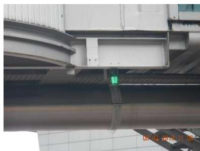
Fig. 46. Emplacement lampe verte du boarding bridge
