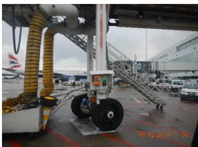
Fig. 46. Emplacement lampe verte du boarding bridge
