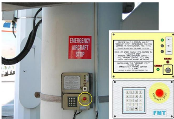
Fig. 53. Arrêt d'urgence jetée B, niveau tarmac
