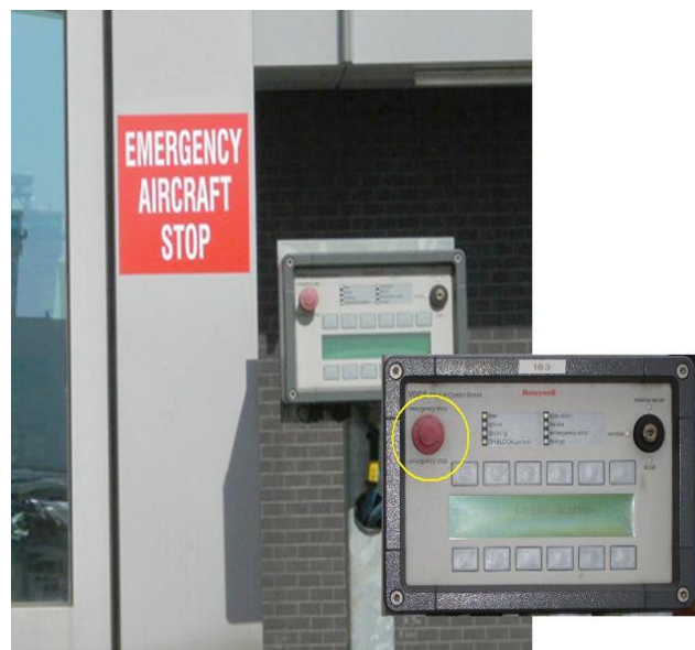
Fig. 52. Arrêt d'urgence jetée Arrêt d'urgence jetée A
