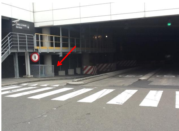
Fig. 59. Locatie metalen bakken pier B
