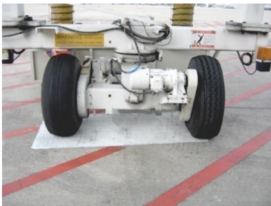
Fig. 45. Rustpositie van de wielen van de boarding bridge
