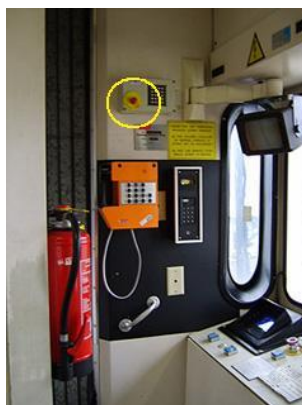
Fig. 55. Arrêt d'urgence jetée B, cabine de commande de boarding bridge
