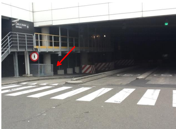
Fig. 60. Endroit du bac en métal au passage souterrain jetée B
