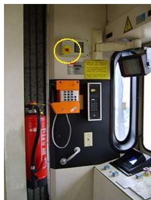
Fig. 54. Arrêt d'urgence jetée B, cabine de commande de boarding bridge
