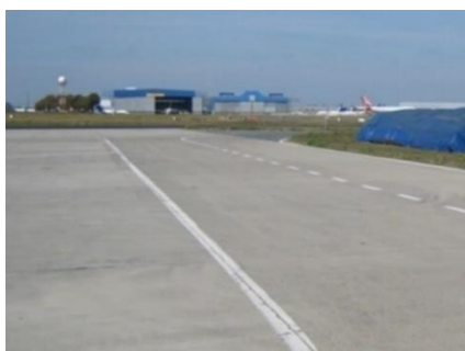
Fig. 4. Service drive: simple ligne blanche
