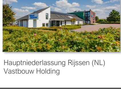
Hauptniederlassung Rijssen (NL) Vastbouw Holding
