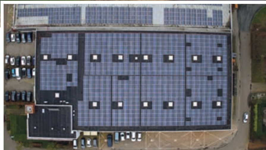
▲ Het gerenoveerde dak in beeld.
