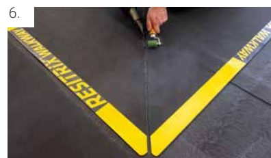
6. Bij richtingsverandering de WALKWAY onder 45° doorknippen en stuik tegen elkaar leggen, met een maximale voegbreedte van 10mm.
