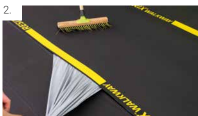
2. Na droging van de hechtprimer de WALKWAY aanbrengen en deze met een zachte bezem aanvegen.
