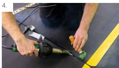
4. De WALKWAY stuikend aanbrengen met een maximale voegbreedte van 10mm.
