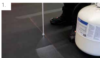
1. Aanbrengen van FG35 hechtprimer binnen het afgetekende gebied, waarbij rekening moet worden gehouden met de breedte van de WALKWAY plus 20mm aan beide zijden.
