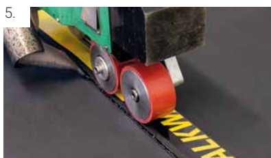
5. De buitenzijde van de WALKWAY thermisch lassen met behulp van een lasautomaat of handföhn.
