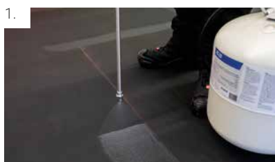
1. Nach der Kennzeichnung der Fläche mittels Schnurschlag (Bahnenbreite zzgl. 20 mm), wird der Untergrund mit FG 35 vorbereitet.
