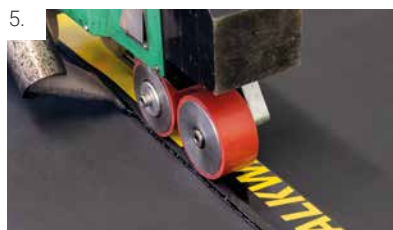
5. Anschließend wird der RESITRIX® WALKWAY auf dem Untergrund verschweißt.
