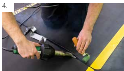
4. Die Bahnen werden mit einem Abstand von 10 mm stumpf gestoßen.
