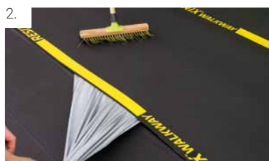
2. Anschließend wird der RESITRIX® WALKWAY positioniert und die Bahn mit einem Besen angedrückt.
