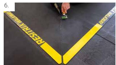
6. Bei einem Richtungswechsel werden die Bahnen im 45° Winkel stumpf gestoßen (10 mm Abstand).
