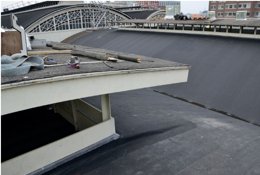
Vanwege het gevaar van doorrollen moest ook de ruimte rond de rookkappen worden beveiligd.
