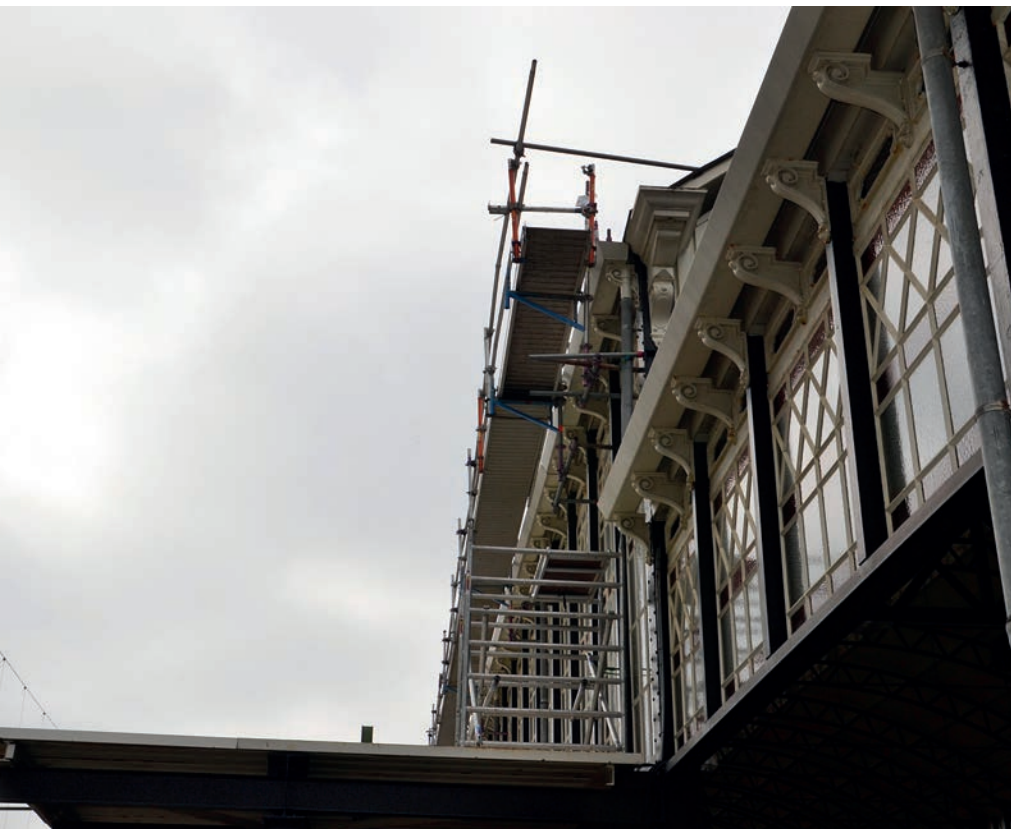
De 148 meter aan steigers is acht keer verplaatst.
