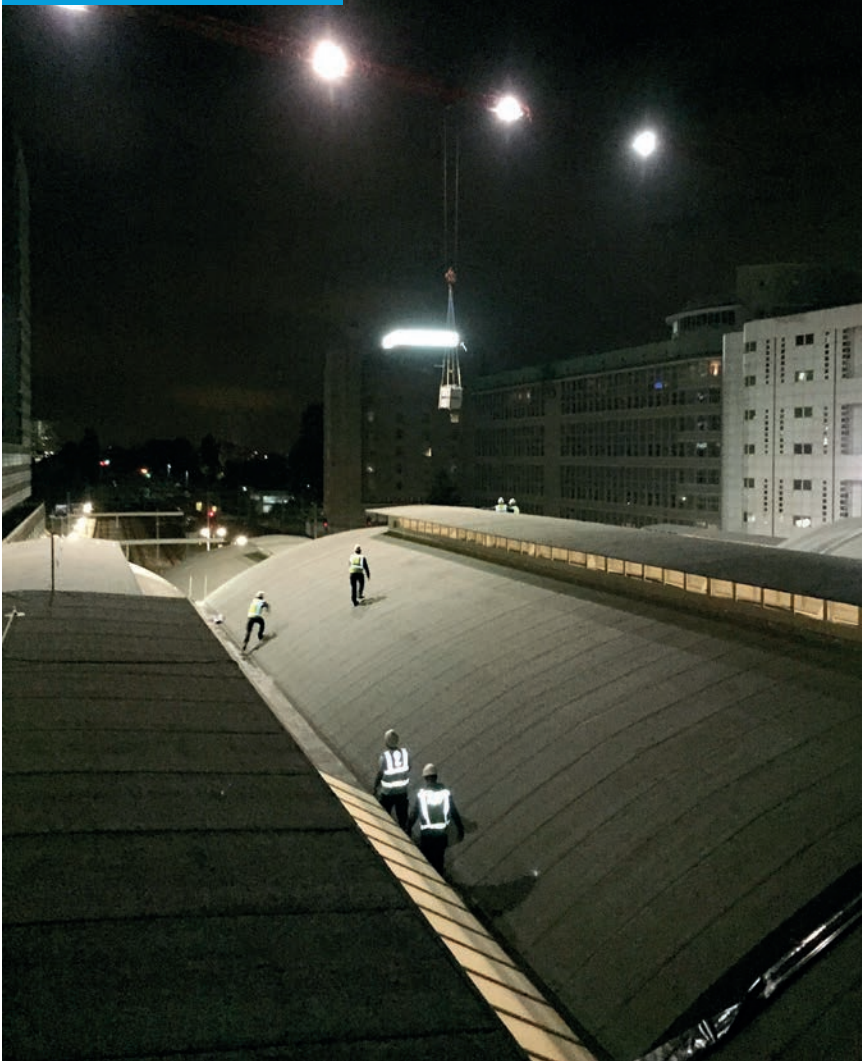
Omdat de buitendienststellingen 's nachts waren gepland, moesten de dakbedekkers regelmatig in de kleine uurtjes aan de slag.
