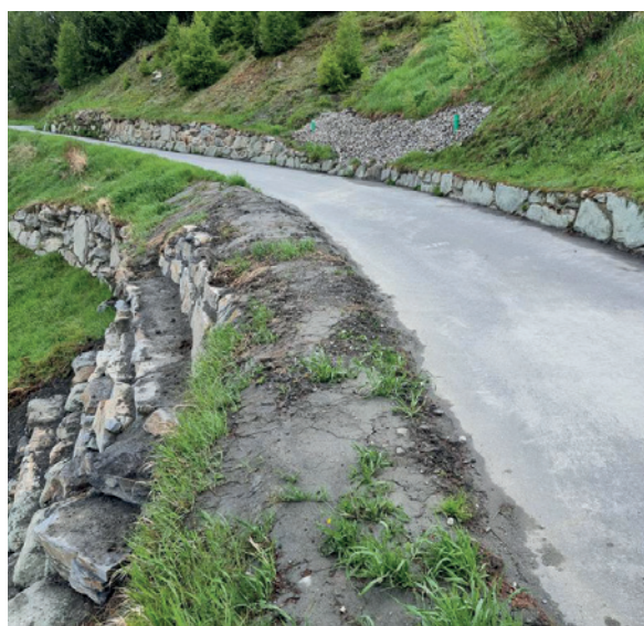
Strasse nach der Instandsetzung
