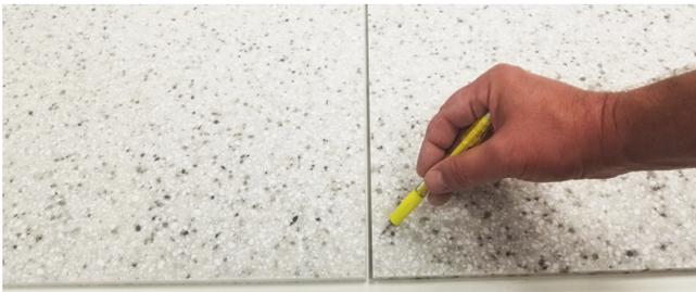
铣好边缘后，进行预装配，以确保边缘平整且准确。在预装配过程中，接缝应基本消失。否则，应重新铣削，再去除 1/16" (1.5 mm) 的材料。然后进行预装配检查。
