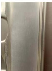
5. Verwenden Sie etwa 10-15 Sekunden lang ein feuchtes 3M Gray Scotch-Brite-Pad, Reinigung mit einem feuchten Tuch, bevor Sie mit dem nächsten Schritt fortfahren.
