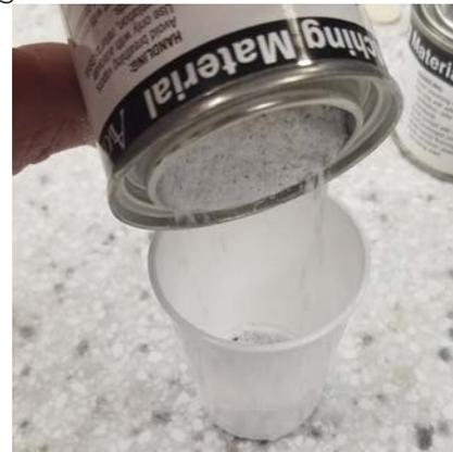
Vergleichen Sie die Farbe, indem Sie in der Nähe des auszubessernden Bereichs eine Wasserpfütze platzieren. Die hinzuzufügende Katalysatormenge muss anhand der verwendeten Harzmenge bestimmt werden, nicht anhand des Gesamtvolumens beider Behälter. (Siehe Abschnitt 4.3)
