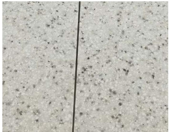
Frotter le dessus de la surface renforce l'adhérence du surplus de colle. Cela permet d'éviter que la partie supérieure critique du joint ne se détache lors de l'usage.
