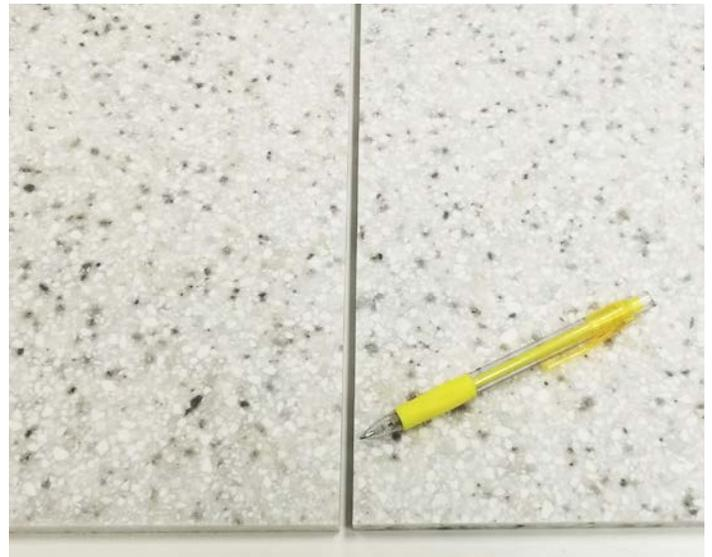
Après le défonçage, contrôler à nouveau la qualité du positionnement à sec. Poursuivre uniquement s'il est correct.
