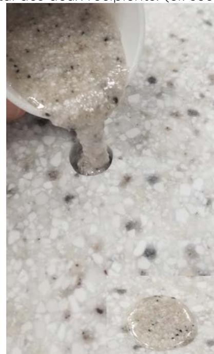
Avec une finition polie, il est difficile d'obtenir la même brillance entre la plaque et le matériau de retouche. Une ampoule de 100 W peut être utile pour chauffer la retouche. Les zones plus grandes doivent être réparées avec une incrustation en matériau Solid Surface correspondant. Les kits de retouche ne doivent pas être utilisés pour réparer un joint mal fait ou cassé (Section 5.3) RÉPARATIONS
