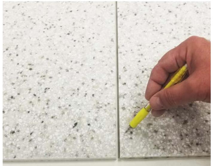
Après avoir défoncé les bords, positionner à sec pour confirmer que le bord est bien plat et droit. Lors du positionnement à sec, le joint devrait quasiment disparaître. Si le joint n'est pas correct, le refaire en retirant encore 1,5 mm (1/16"). Contrôler en positionnant à nouveau à sec.
