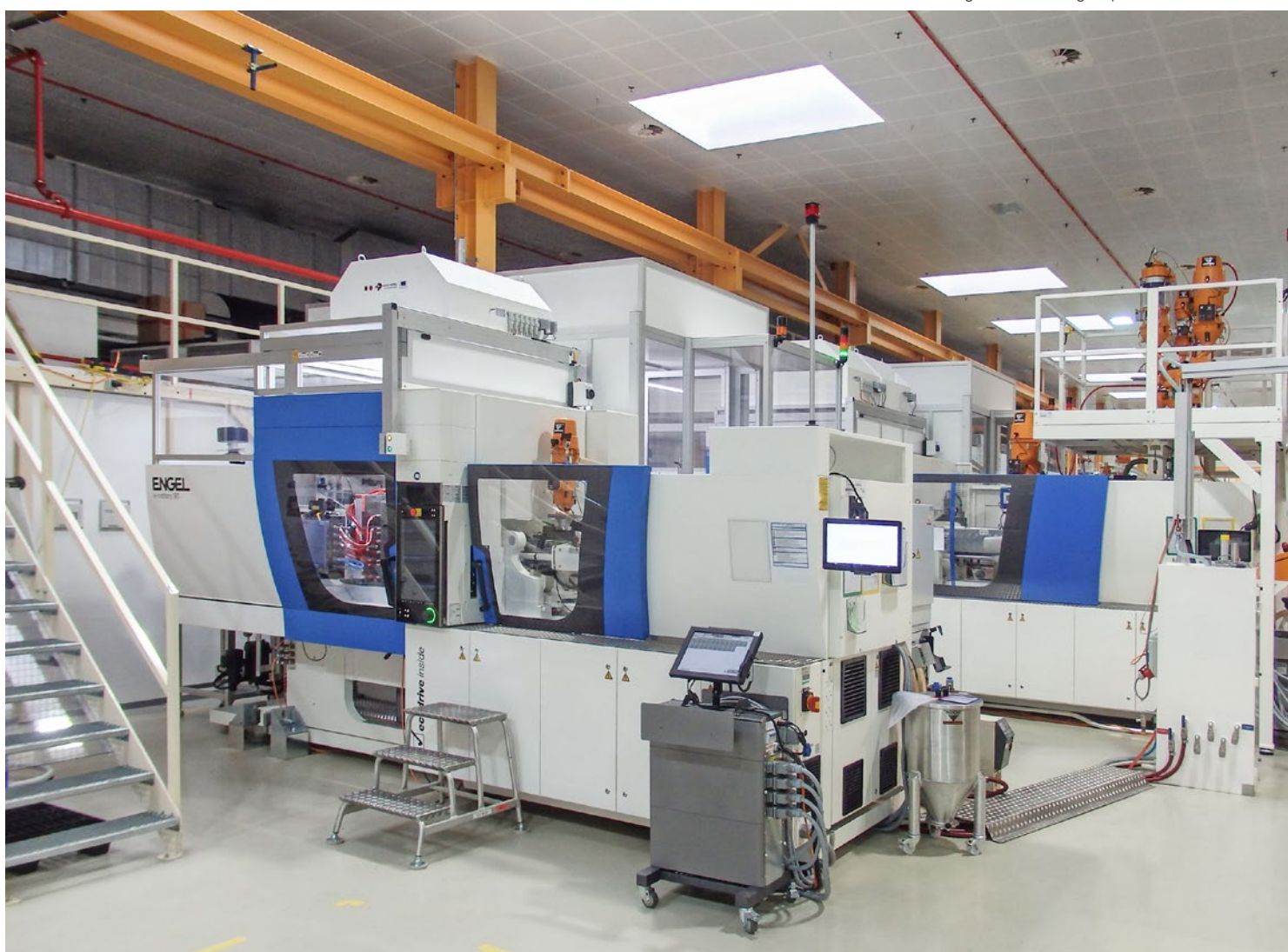
Spritzgießmaschinen und Automatisierung sind jeweils in reinraumgerechte Produktionseinheiten – Anforderungen an ISO 7 – gekapselt.
