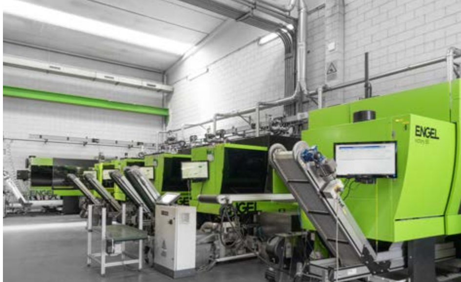
Il reparto di produzione è dotato di presse a iniezione Engel senza colonne, tecnologia che permette installare stampi di grandi dimensioni su macchine di tonnellaggio inferiore, riducendo consumi e ingombri
