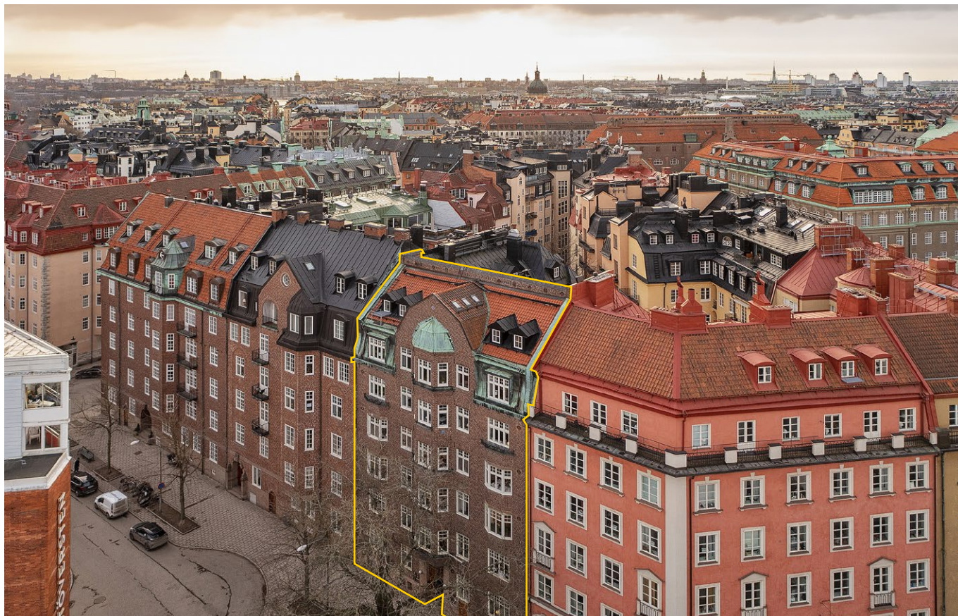
Spiltanhuset med adress Erik Dahlbergsallén 15 på övre Östermalm. Vy från Valhallavägen.
