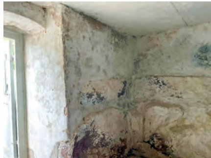
Keller im linken Turm
