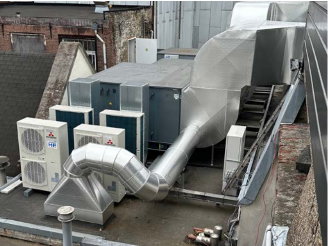
De nieuwe dakinstallatie.
