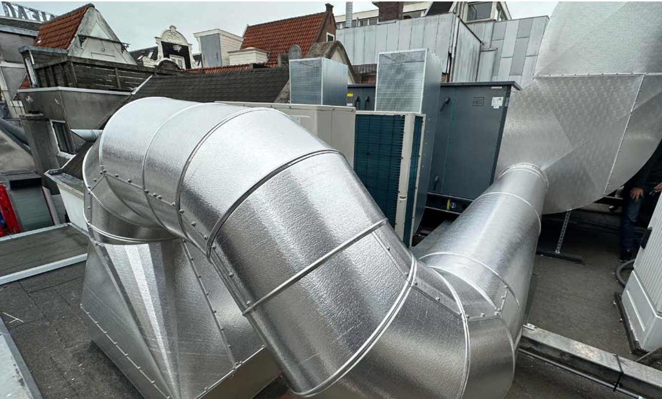
Omdat in de nieuwe situatie wordt gewerkt met geconditioneerde lucht, is het dakkanaalwerk geïsoleerd en afgewerkt.
