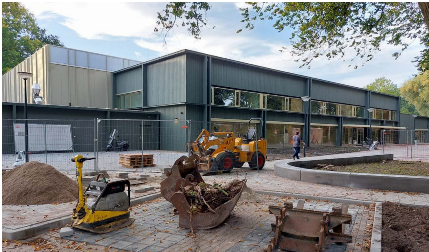
In totaal heeft Systemair vier luchtbehandelingsunits geleverd, voor de vier gebruikersfuncties in de MFA.
