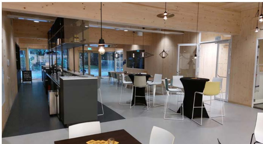
De nieuwbouw is grotendeels opgetrokken in Cross Laminated Timber; een biobased constructie met een mooie uitstraling die ook direct als wandafwerking is gebruikt.
