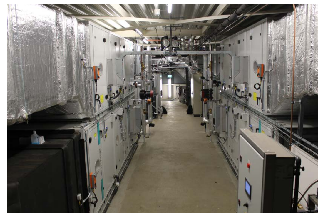
Omdat het Antoni van Leeuwenhoek een bestaand ziekenhuis betreft met een gesloten dak en gevels, zijn de units opgedeeld in handelbare secties en op locatie samengebouwd.
