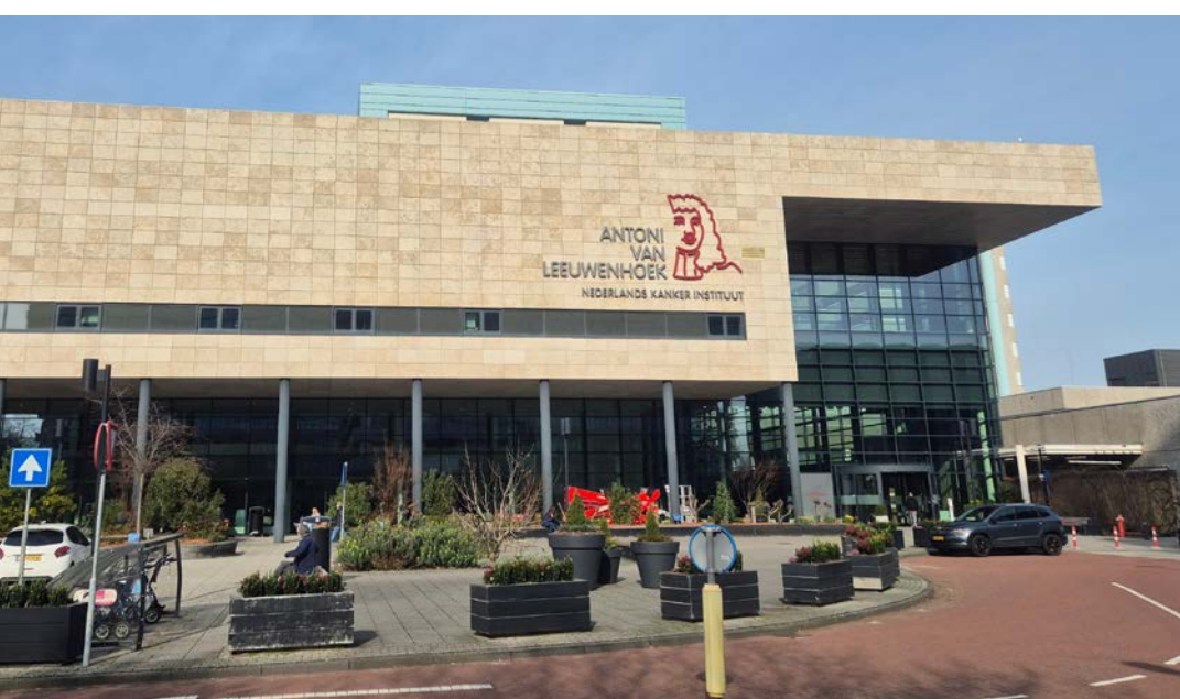
Afgelopen jaar heeft Systemair de luchtbehandelingsinstallatie in het ziekenhuis geüpgraded, waarbij bestaande luchtbehandelingsunits zijn gerenoveerd en verduurzaamd. Ook zijn twee bestaande units vervangen.
